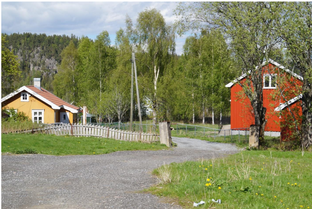
Sølvedt skole ligger til venstre og overtas av Solum Historielag i 2017 Foto: TAU Læreboligen på Sølvedt ligger til høyre og er lagt ut for salg (kommunen)
