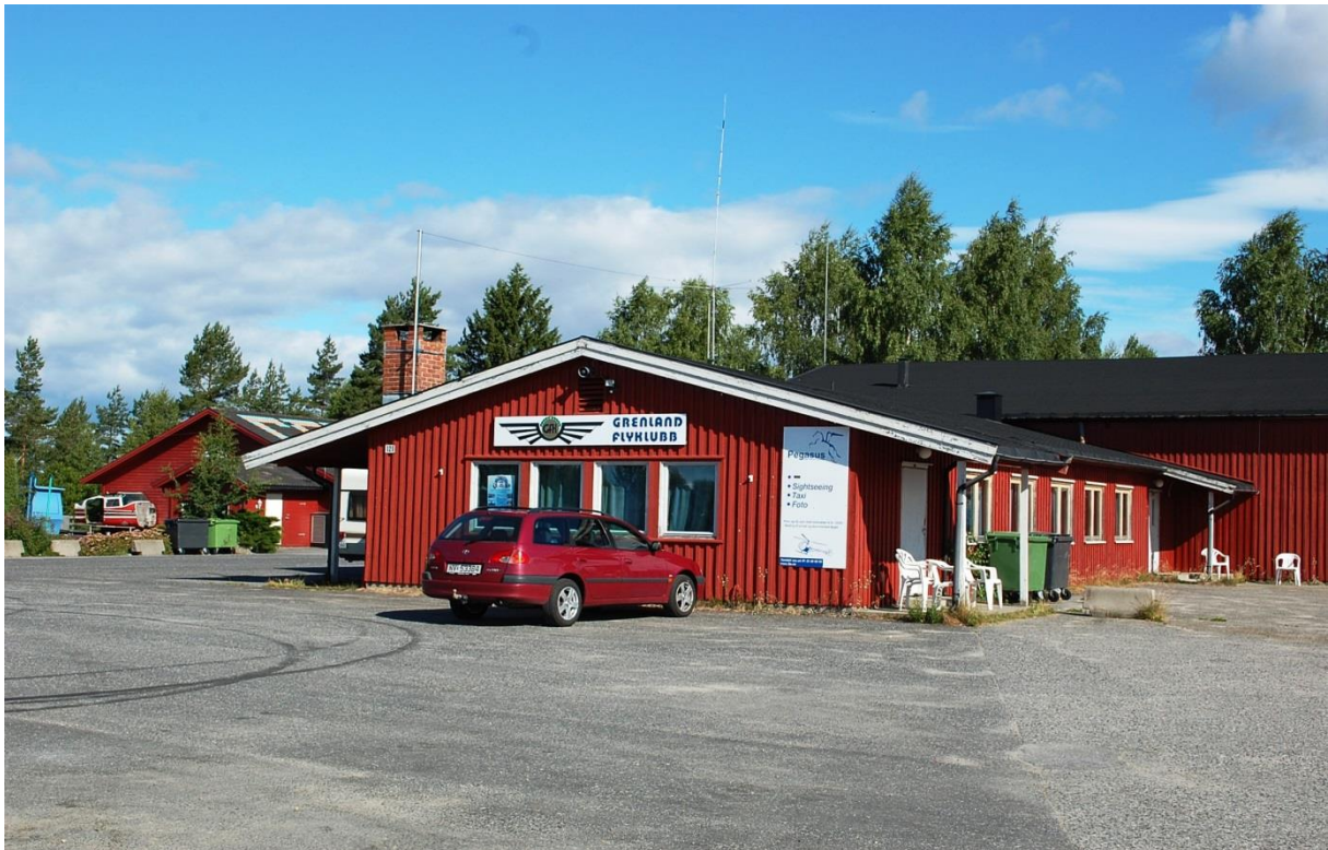
Foto: TAU: Den første «terminalen» - servicebygget til flyplassen med kafeteria. Bildet er tatt fra plassen der bjørnegården til Bamse og Tasselass lå.
