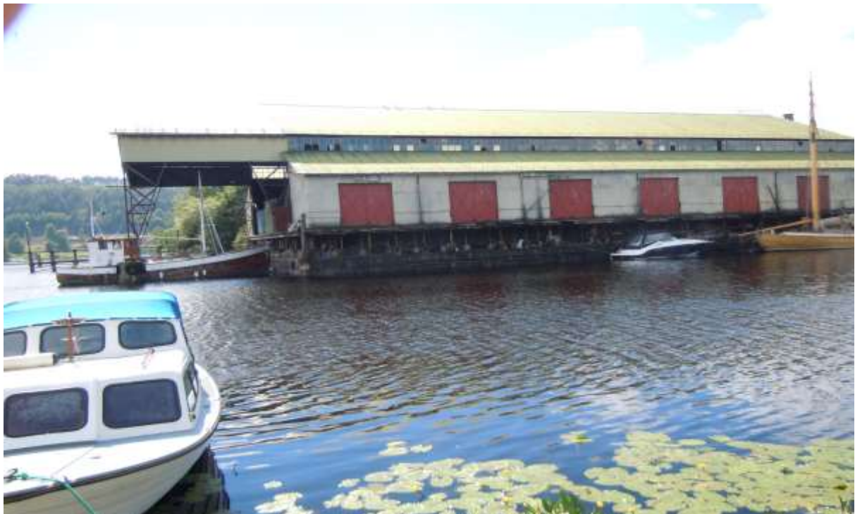
Her ser vi brygge og lagerhu. Under lagerhuset ser vi tydelig den opprinnelige gråsteinsmuren som ble bygget på begynnelsen av 1900 – senere hevet ca 1m.
